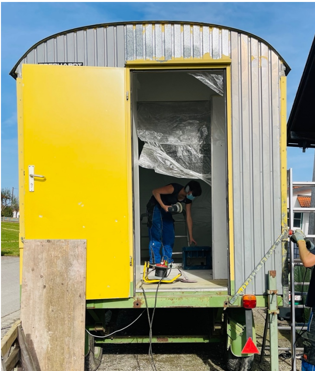
Unterkunft für den Waldkindergarten während der Umbauarbeiten.
