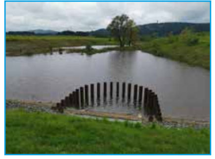
Burggen: Technischer Hochwasserschutz
