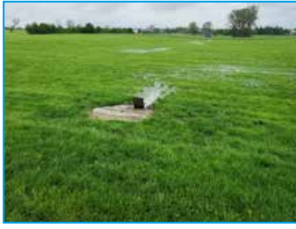
Altenstadt: Rückhaltung in der Fläche durch Wege-Erhöhung und gezieltem Ablauf
