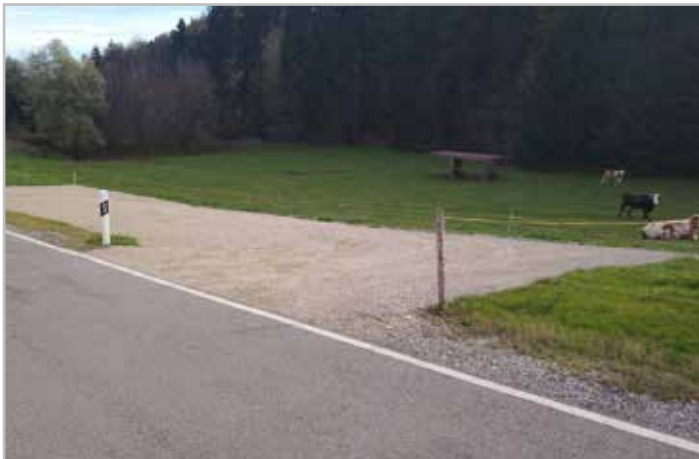
Wanderparkplatz mit Wassergebundener Decke am Fuße des Auerberg, am Ausgangspunkt der Wanderroute
